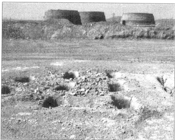
تصویر ۱: نظم روزنه‌های آتش بر سطح زمین در کوره‌های گردچین قمی قبل از چیده شدن خشت‌ها
