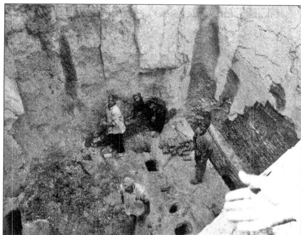
تصویر ۵: کوره آجرپزی از نوع چاله‌یی حین تعمیر و آماده شدن برای پخت، کوره‌های آجرپزی منطقه دزفول - خوزستان
